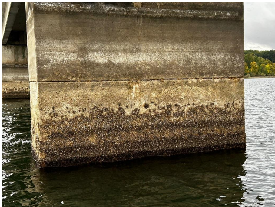
Abbildung 8: Quaggamuscheln am Brückenpfeiler, Körbecker-Brücke
